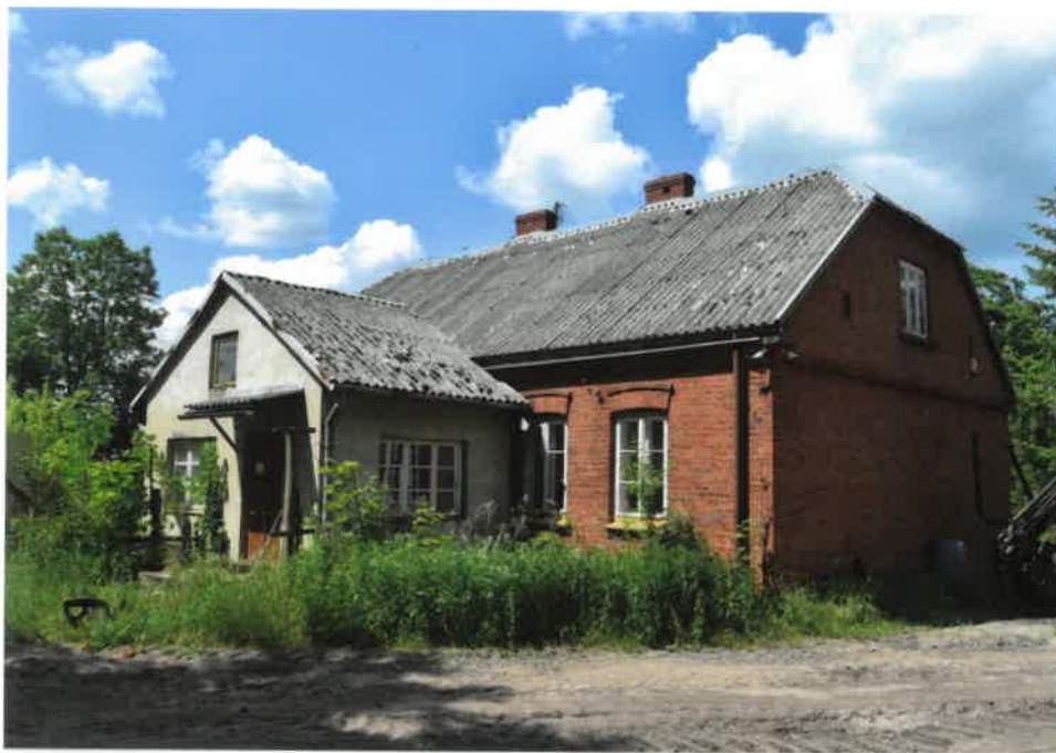
1. Widok od południowego wschodu.
