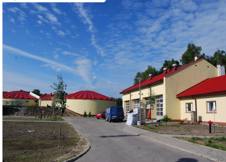
Oczyszczalnia ścieków w Pilawie
